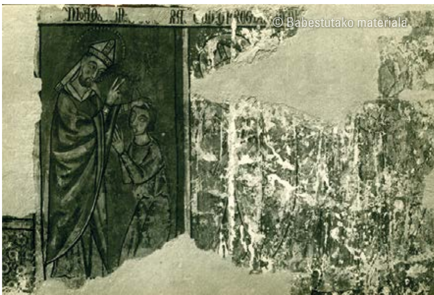
6-7. San Ermengol, debruak hartutakoa exorzizatzen, eta aldameneko eszena bat Francesc Serra Dimasen argazkiak, lehenengo eszena zaharberritu baino lehen eta zaharberritu ondoren Arxiu Fotogràfic de Barcelona
