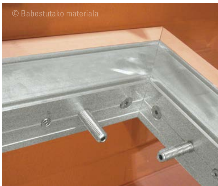
14. Autotentsioko armazoiaren xehetasuna
