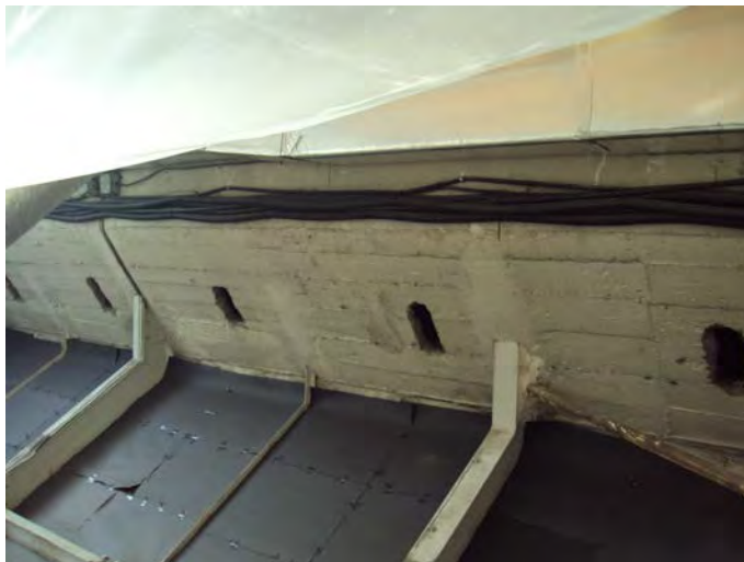
IM 06 Bajocubierta Sala 4.
