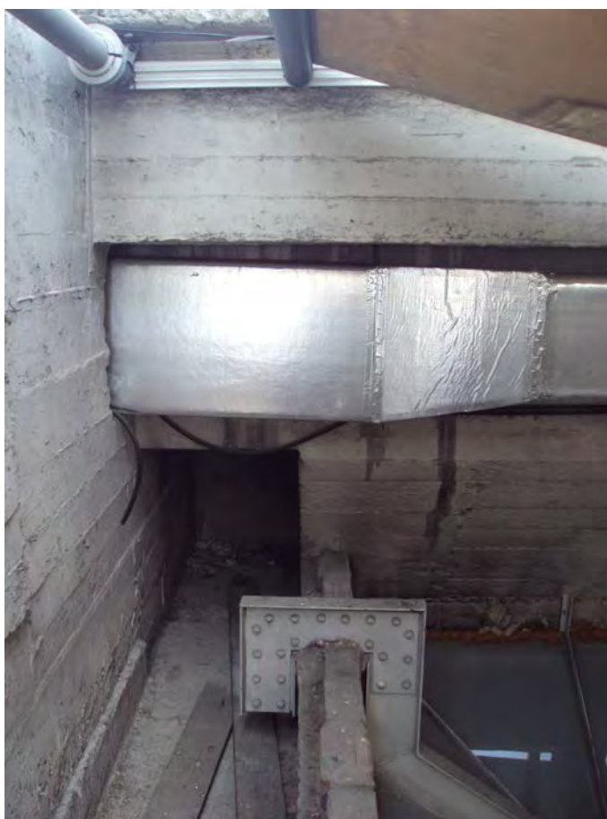
IM 02. Detalle de anclaje Salas 21-31 excepto la 22.
