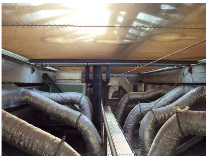
IM 04. Bajocubierta Sala 9.
